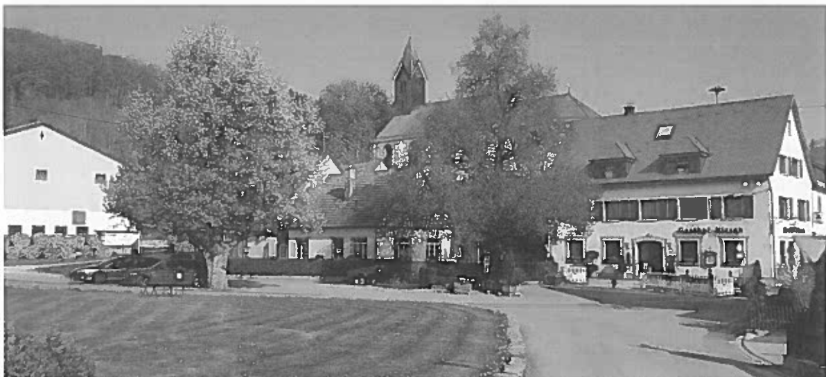
Blick vom Ringwallweg auf den Dorfplatz
