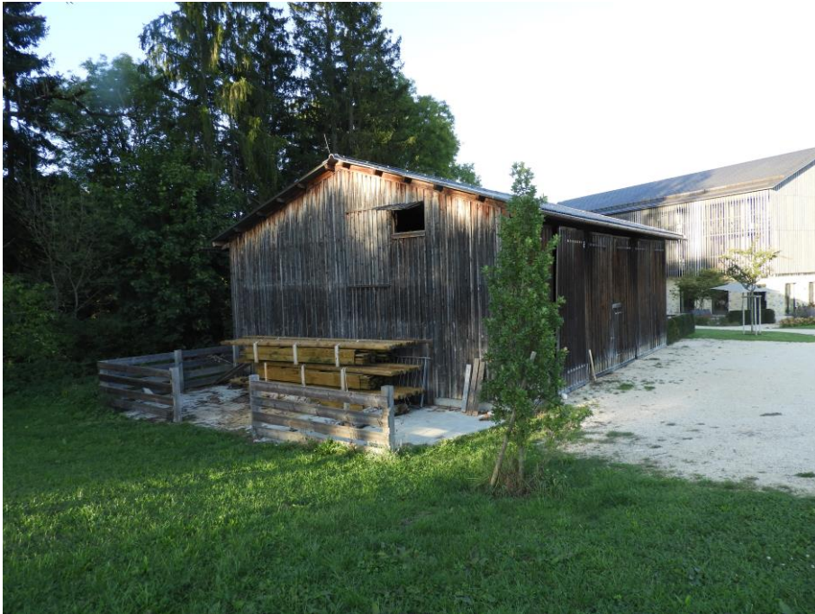
Abb. 4: Die bestehende Scheune von Südwesten
